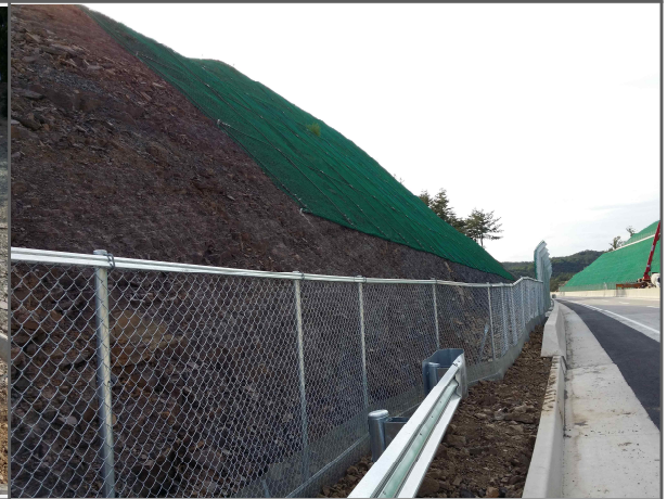
② 절토사면 시공 현황(중점 횡단)
