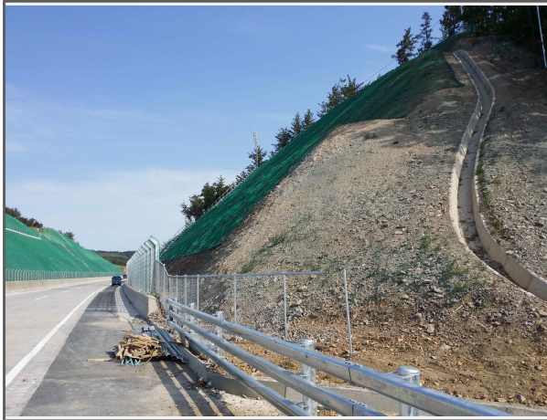
① 절토사면 시공 현황(시점 횡단)
